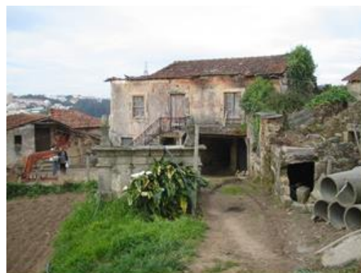
Edifício principal – vista interior da quinta Fonte: Fichas de Património Arquitetónico do PDM
