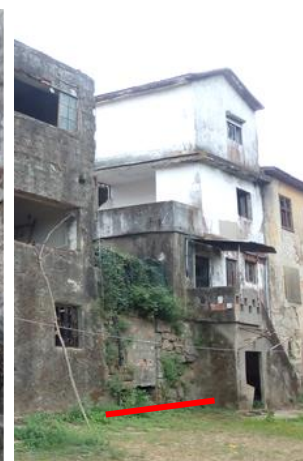
Fachada poente voltada para o rio Febros
