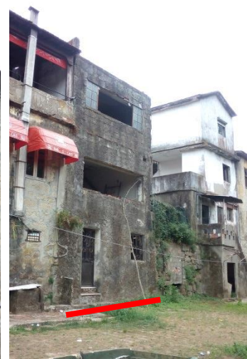
Fachada poente voltada para o Rio Feбros
