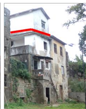
Fachada poente voltada para o Rio Febros
