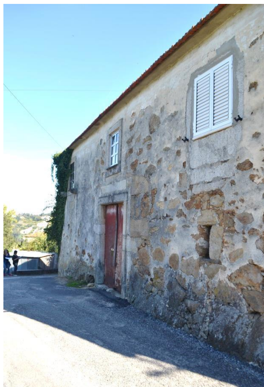
Fachada principal voltada para a Rua
