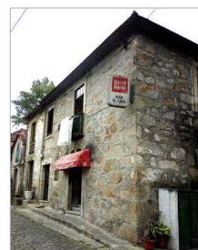
Fachada voltada para a Rua do Esteiro
