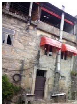
Fachada voltada para o rio Febras
