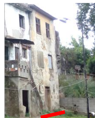
Fachada poente - voltada para o Rio Febros
