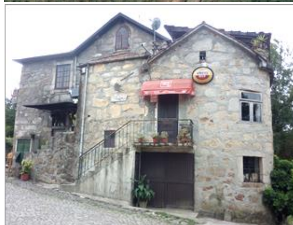
Edifício de gaveto - fachada voltada para a Rua do Esteiro
